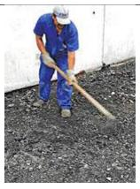
2º)- Passo - **Compactar a área**, em partes pequenas pode-se usar soquete, em áreas maiores, é preciso o **auxílio de placa vibratória ou rolo vibro compactador**.
