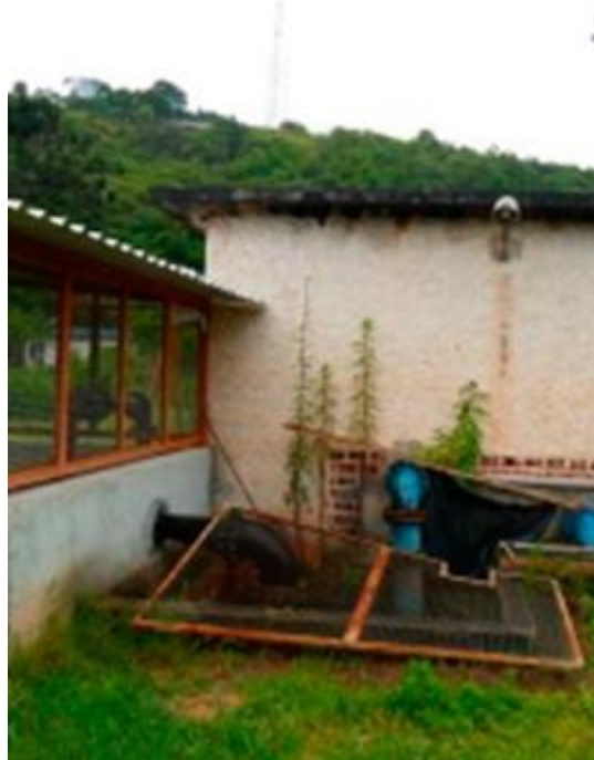
Foto 2 – Detalhe do poço de sucção da captação
