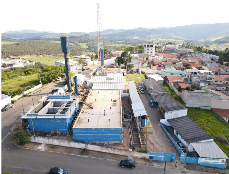
Foto 4 – Nova Estação e Reservatórios
